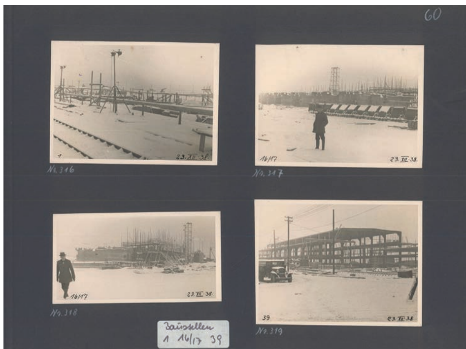
Abb. 22: Seite eines großformativen Albums mit Baustellenfotos aus dem Jahr 1939. Foto: Stadtarchiv Wesseling.
