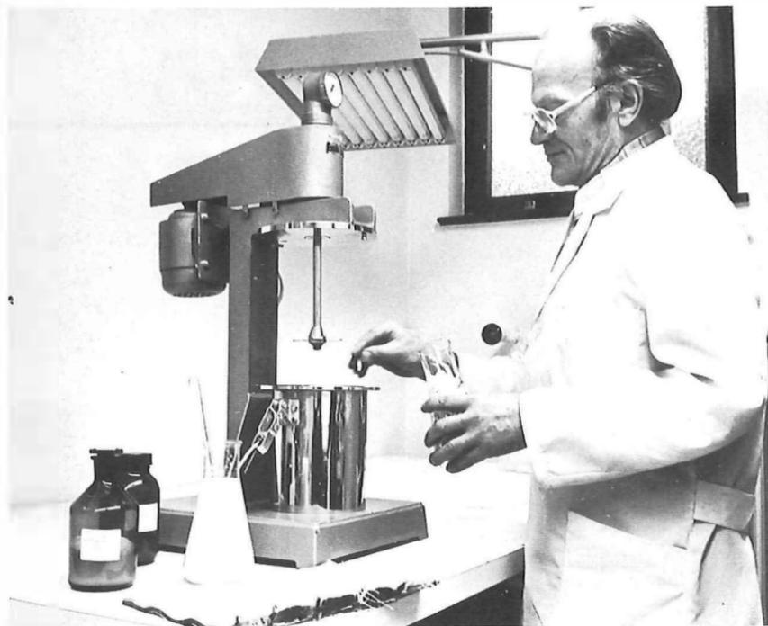
*Abb. 24 Aufschlaggerät zur Fertigung des Papierbreis für die Anfasung.
