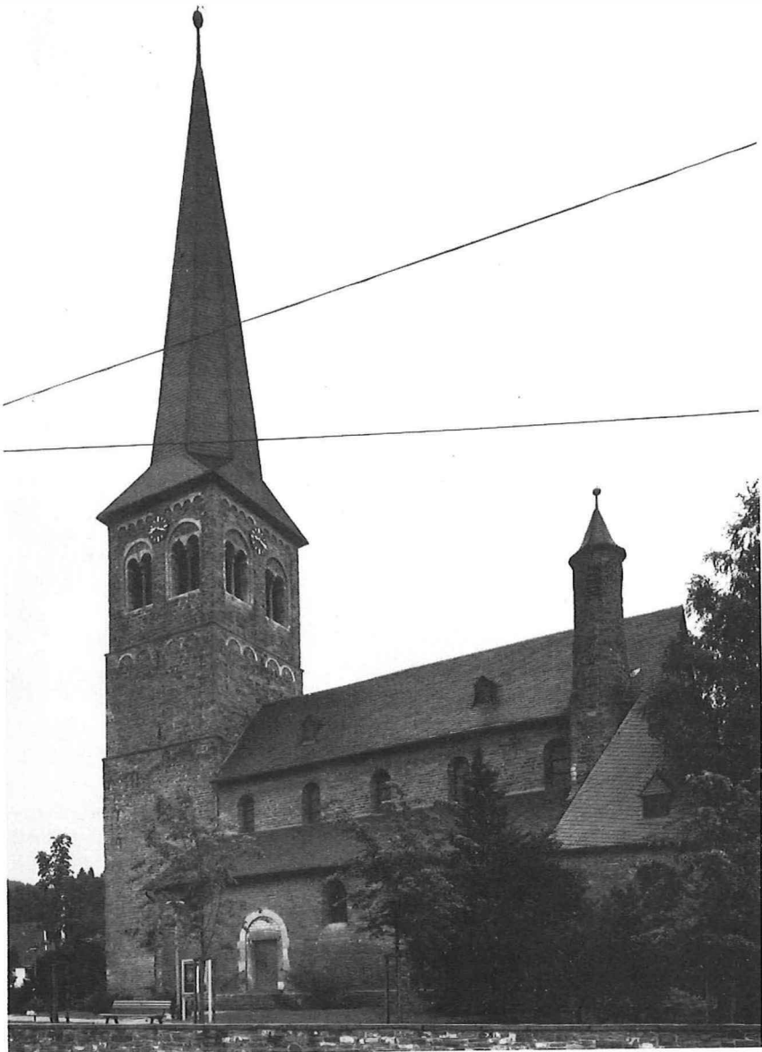
Abb. 2: St. Walburga-Kirche zu Overath. Für die Instandsetzungsarbeiten am Turm hatte die Gemeinde einzustehen (Nr. 1). Die Gelder wurden durch eine Umlage erhoben (Nr. 7).
