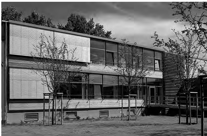
Archiv des Landschaftsverbandes, Bürotrakt des 2004 bezogenen Archivneubaus, ALVR: Foto LVR-Zentrum für Medien und Bildung
