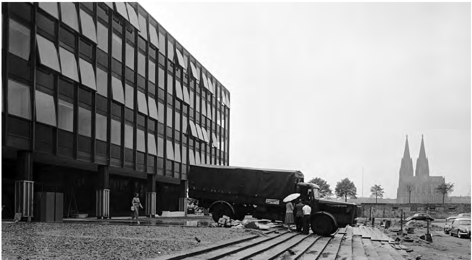
Landeshaus Köln kurz vor der Fertigstellung, Dienstsitz 1959–1977, Foto LVR-Zentrum für Medien und Bildung, Foto Walter Klein 1959
