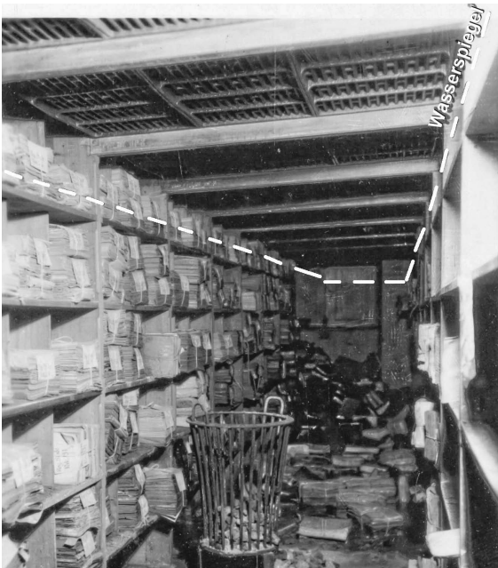
Abb. 7: Verschlammtes Magazin des Hauptstaatsarchivs Hannover nach dem Leinehochwasser von 1946 (NLA Hannover BigS Nr. 7488/21). An der Strichmarkierung ist die Höhe des Wasserstands des Hochwassers erkennbar. Foto: Franz Engel.
