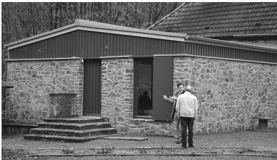
Abb. 3: Außenansicht des neuen Archivgebäudes auf Schloss Hugenpoet kurz vor der Fertigstellung; im Vordergrund: Maximilian Freiherr von Fürstenberg und Dr. Hans-Werner Langbrandtner, LVR-AFZ.
