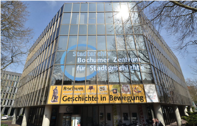
Abb. 7: Das Gebäude an der Wittener Straße. Foto: Stadtarchiv – Bochumer Zentrum für Stadtgeschichte.
