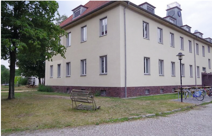
Abb. 2: Bereits fertig gestelltes Lehrgebäude für die o. g. Fachbereiche auf dem Hochschulcampus „Bornstedter Feld“. Foto: Susanne Freund.
